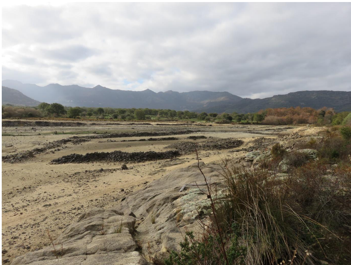
Barrage d'E Cotule, 24 janvier 2018
