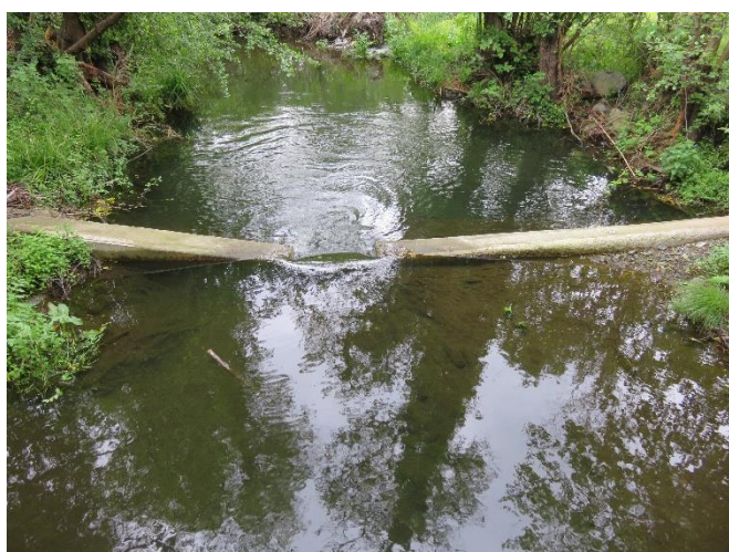
Figure 169 : Seuil de la station hydrométrique du Luri
