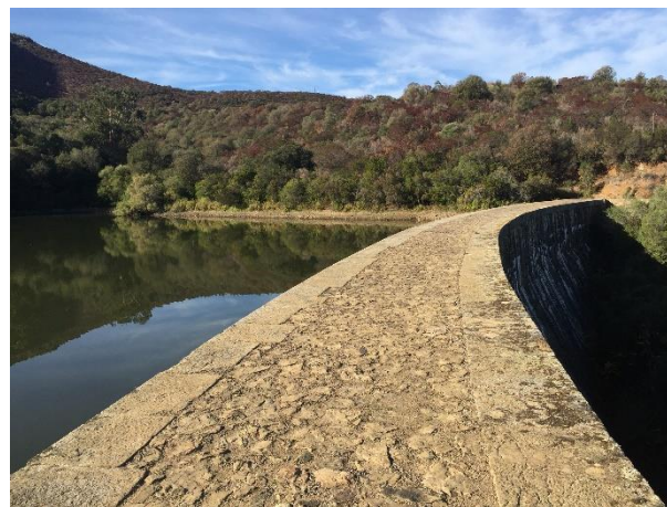
Figure 144 : Digue du barrage de l'Argentella
